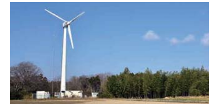
▲100kW風力発電装置
