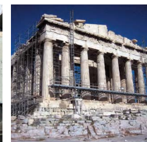
▲世界遺産の耐震調査ーパルテノン神殿ー
