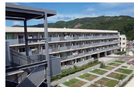
▲建設された災害公営住宅(東北地方)
